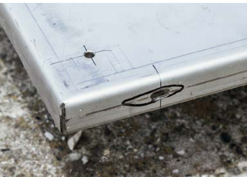
Die Bleche kommen gekantet auf den Hof. Die Stege stehen um 1,5 cm nach unten über. Das oben in der Ecke gebohrte Loch dient der zusätzlichen Fixierung der Platten auf dem Boden mit einer Schlagdübel-Schraube.
