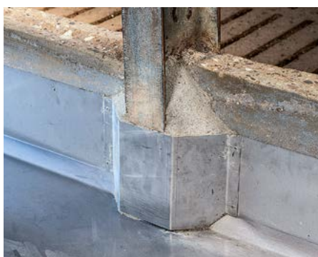
Vor der Sanierung war die Stützsäule ringsum mit gammeligem Futter zugesetzt. Durch die auf Maß gefertigten Bleche können die Säulen verkleidet und der Hohlraum anschließend mit Beton ausgegossen werden.
